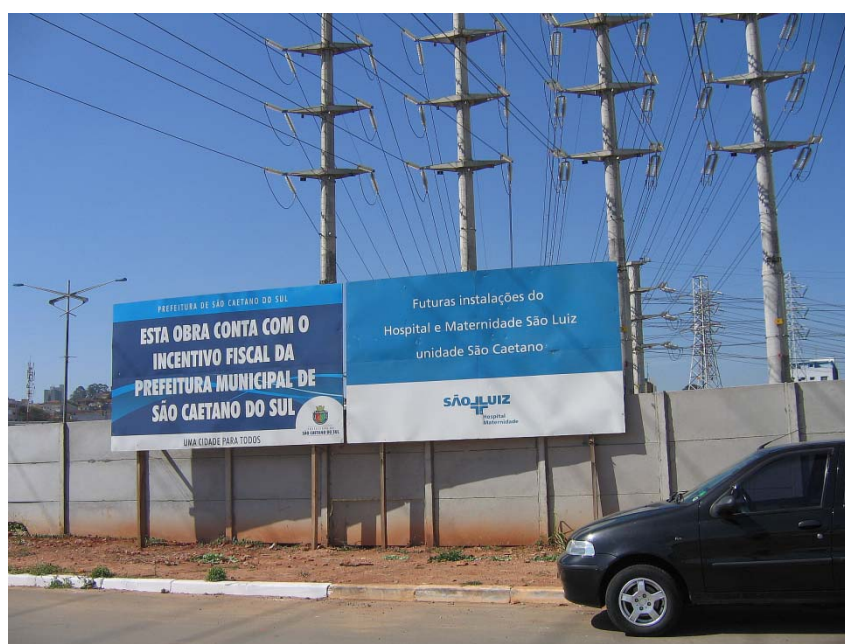
Foto 03– Local do futuro empreendimento.
