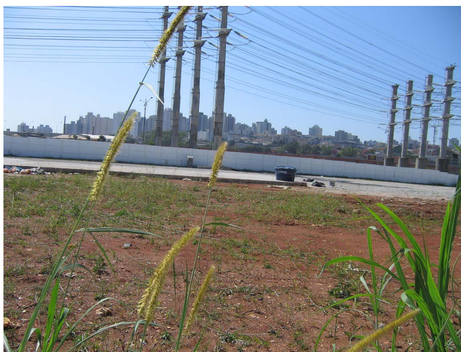
Foto 05– Vista da área interna do terreno.
