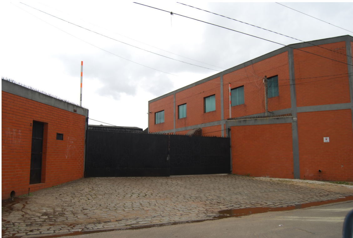
Foto 10– Vizinhança Imediata – Rua Barão de Mauá – Uso industrial. Quadra com edificações e galpões de uso industrial.
