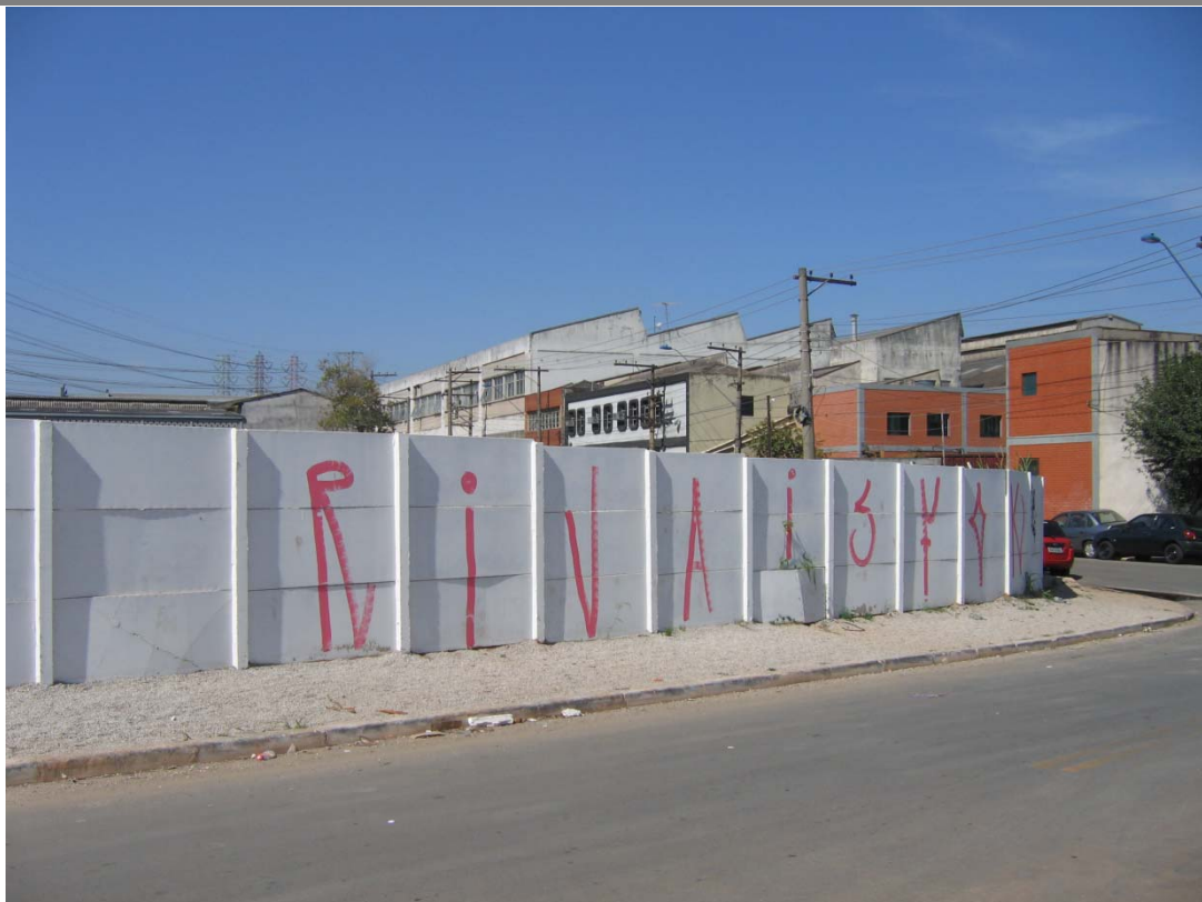
Foto 18– Muro do futuro hospital. Notar o uso industrial ao fundo.
