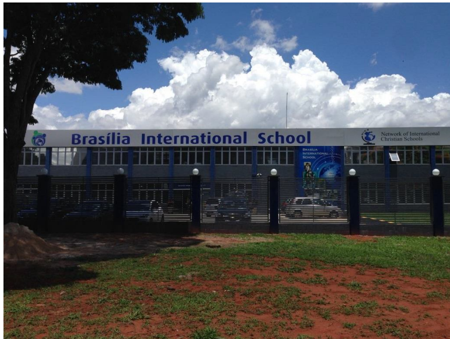
Figura 31: Escola Internacional de Brasília. Fonte: Master Ambiental, 2017
