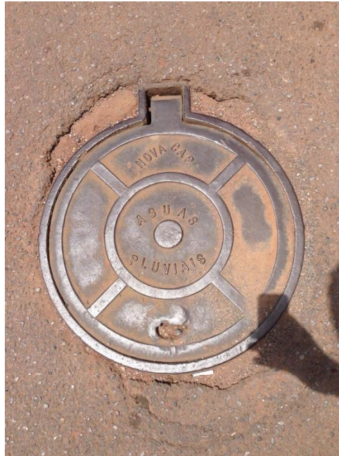
Figura 24: Galeria Águas Pluviais Frente ao Empreendimento Fonte: Master Ambiental (2017)
