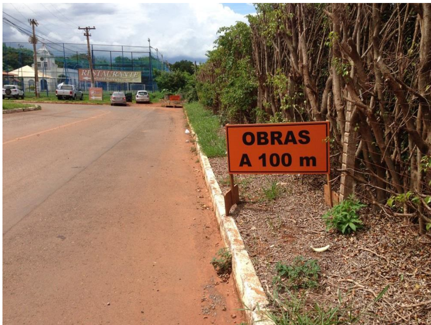
Figura 38: Calçamento precário na AID Fonte: Master Ambiental (2017)
