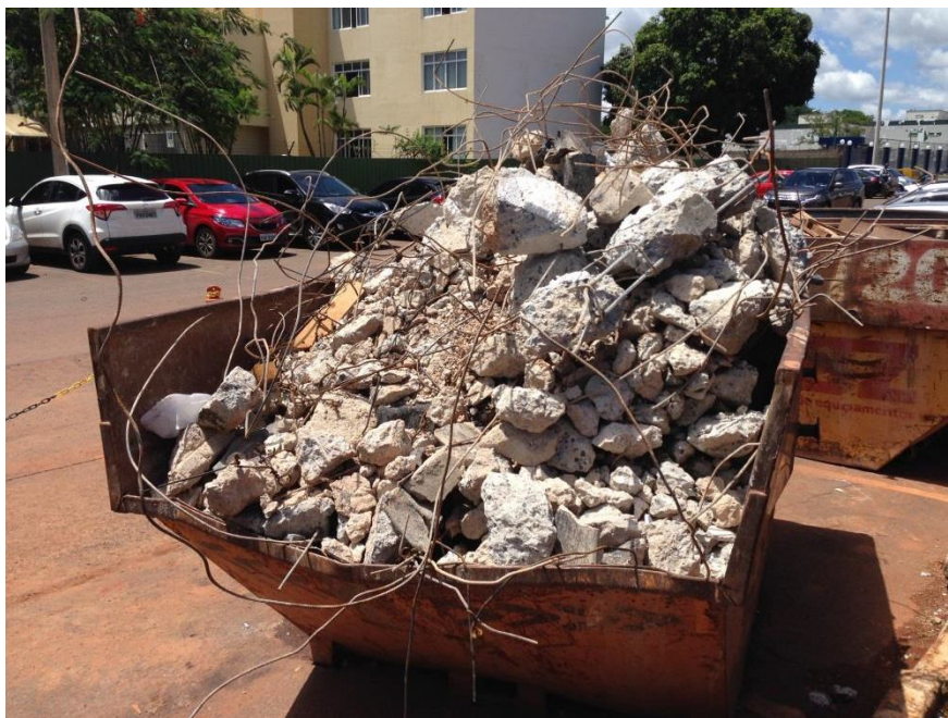
Figura 28: Descarte de Material do Empreendimento- Demolição Fonte: Master Ambiental (2017)
