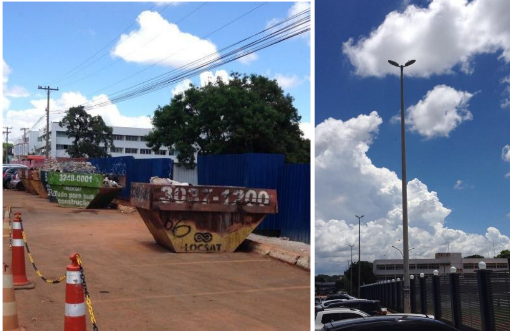
Figura 22: Rede de distribuição de Energia Elétrica Fonte: Master Ambiental (2017)
